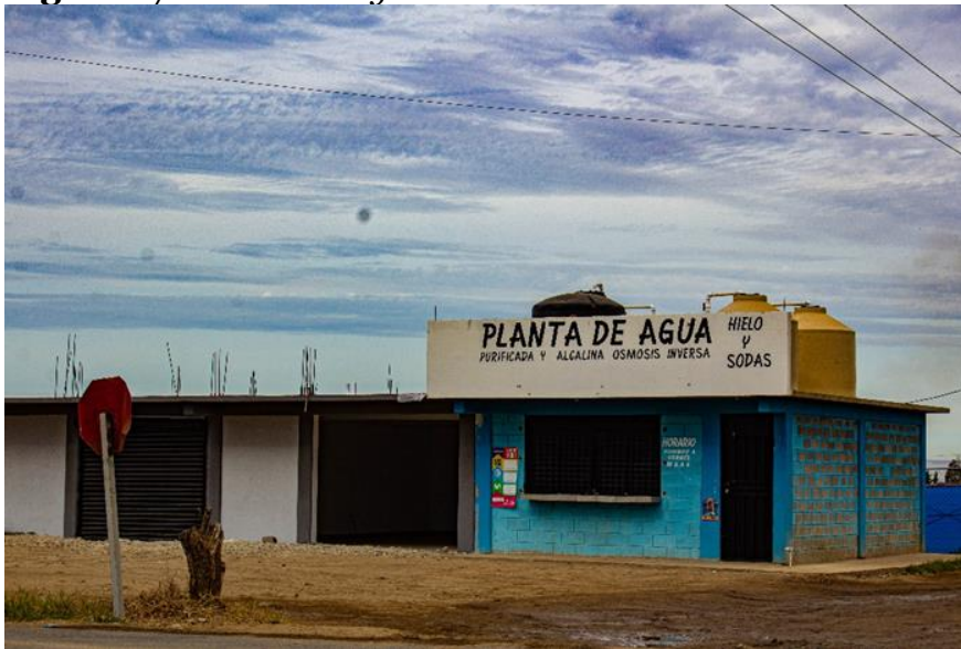
Figura 17. Planta de agua de la comunidad
